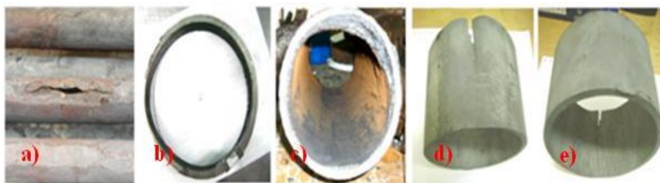
Fig. 1. Tubo con falla: a) rajadura pasante causada durante la prueba del martillo, b) contornos de la sección transversal del tubo, expuestos sobre un papel, c) depósitos adheridos en superficie interior, d) cambio de coloración en la superficie exterior y e) superficie externa opuesta a la falla.
