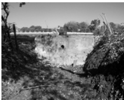
Fig. 6 Impermeabilización con arcilla.
